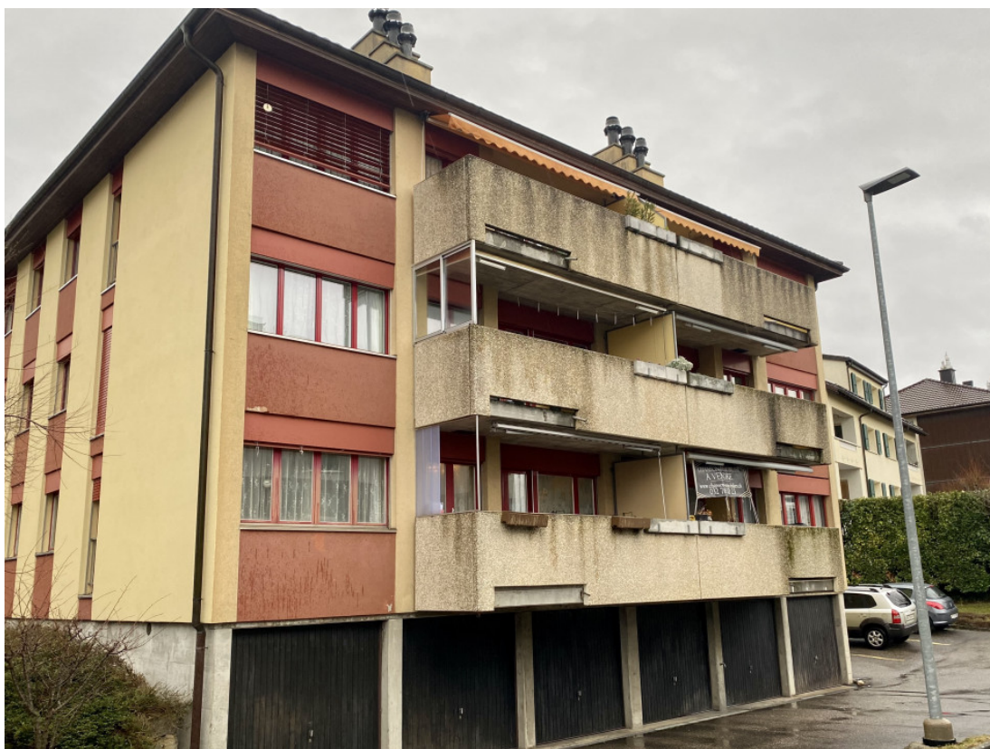
Immeuble (façade sud)
